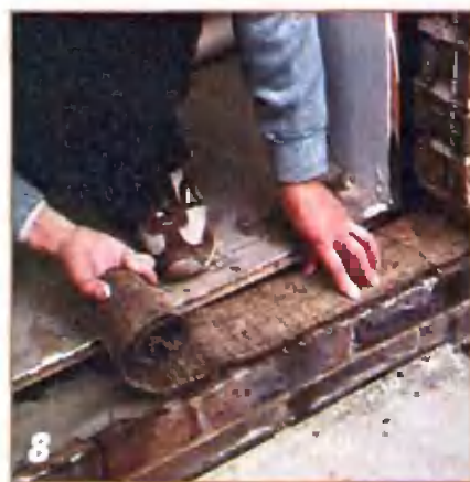
8 Укладывают гидроизоляцию.
