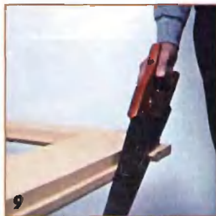
9 Часто дверь поставляют с выступающими «клыками», предохраняющими ее при транспортировке. До установки двери на место отпиливают «клыки».
