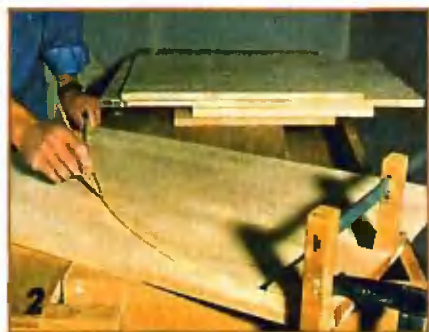
2 Чтобы линия дугообразного закругления получилась плавной и красивой, ее проводят, используя изогнутую деревянную планку, жестко зафиксированную в начальной и конечной точках закругления.
