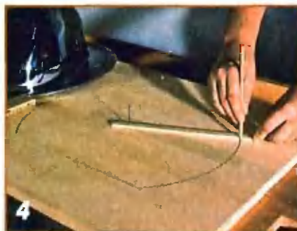
4 Разметку выреза под раковину можно сделать с помощью снятого с нее шаблона.
