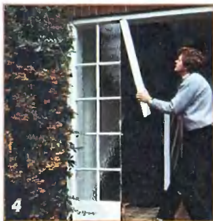
4 Удаляют верхнюю часть стойки, а затем нижнюю.
