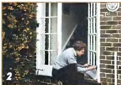
2 Для замены сначала снимают дверь с петель.
