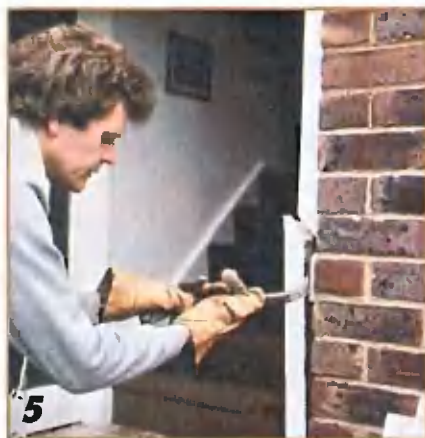
5 Таким же способом удаляют другую стойку.
