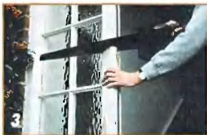
3 Чтобы удалить коробку, распиливают вертикальную стойку по горизонтали.
